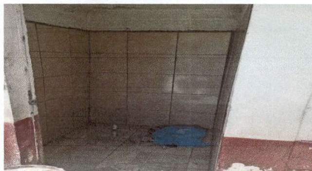
Foto 4: Colocación de cerámico
