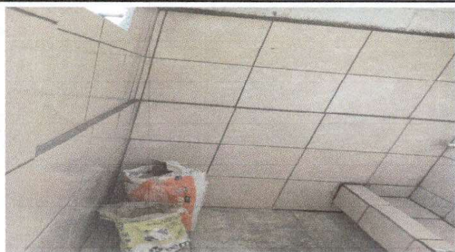
Foto1: Construcción de mingitorio y colocación de cerámico
