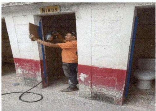
Foto 3: Colocación de puertas
