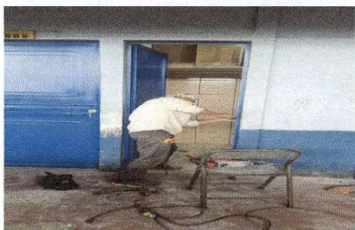
Foto 5: Colocación de puertas
